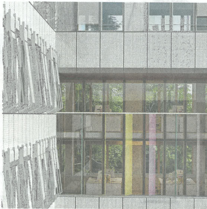
La rénovation en profondeur de l'immeuble fera appel à l'économie circulaire. © D.R.
